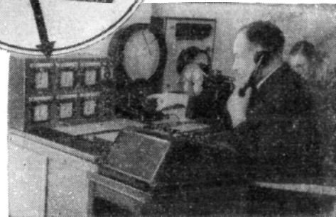
Телеизмерение по телефону температур, давлений и расходов жидкостей и газов в шести точках системы теплоснабжения.
